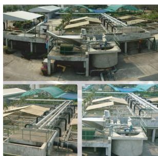
ระบบแอ็กทิเวเต็ดสลัดจ์ (AS)
