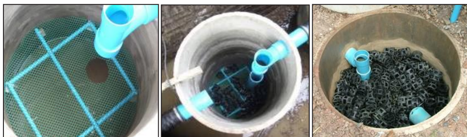
รูปที่ ๓.๑๓ การติดตั้งชั้นตัวกลางภายในบ่อกองไว้อากาศ
